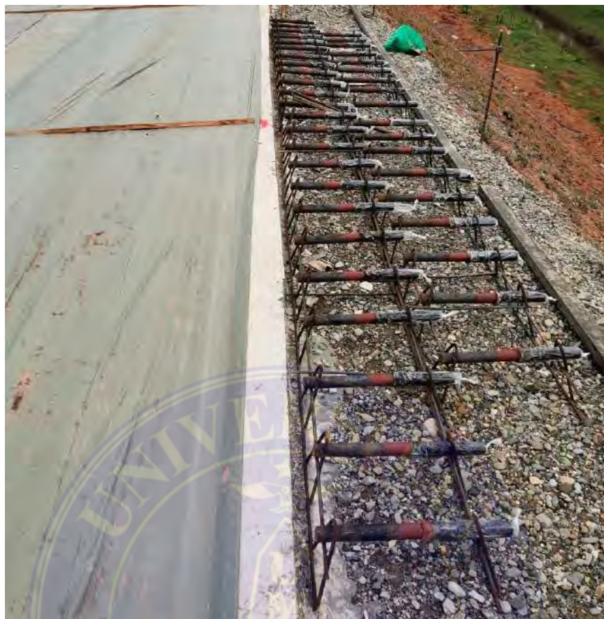
Penempatan Dowel
