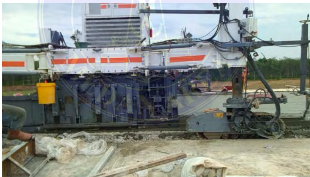
Alat pencetak perkerasan kaku digital ( wirtgen )
