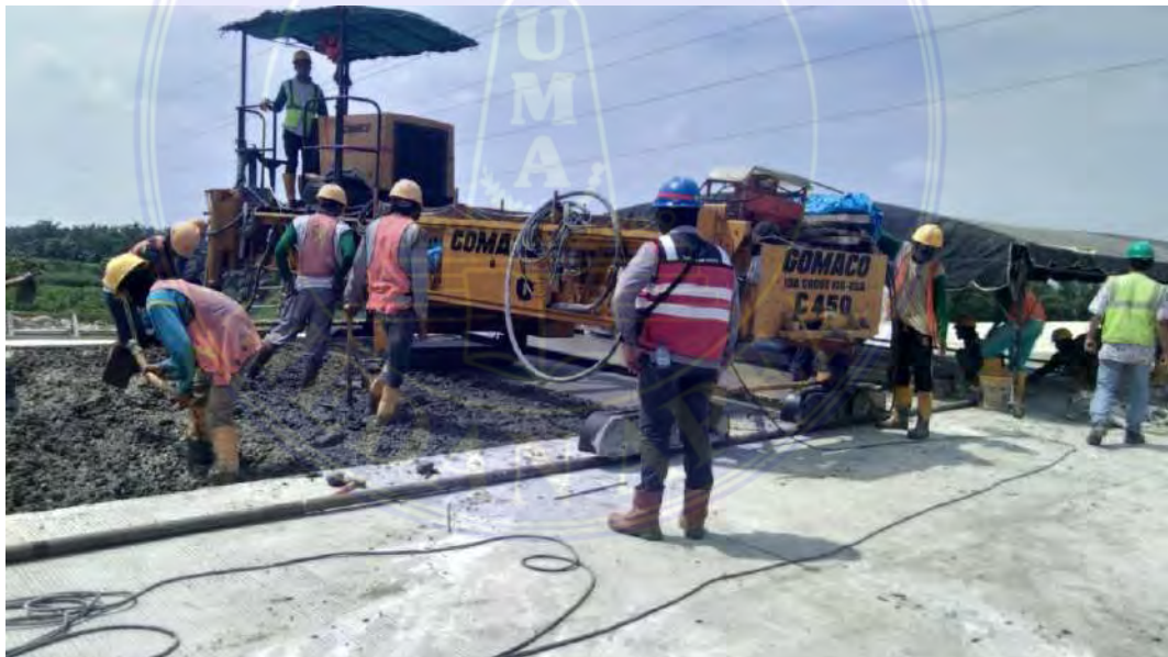
Proses meratakan perkerasan kaku secara manual
