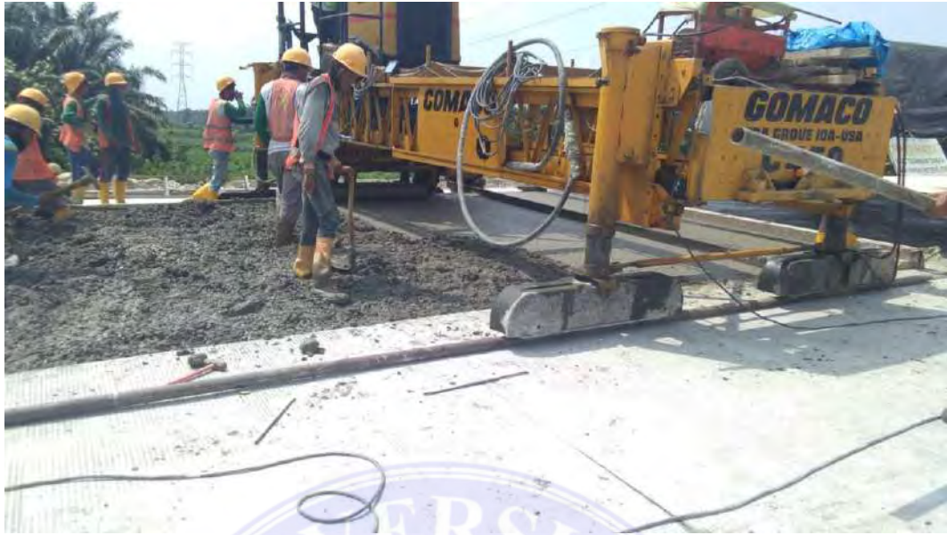
Alat untuk meratakan perkerasan kaku manual ( Gomaco )
