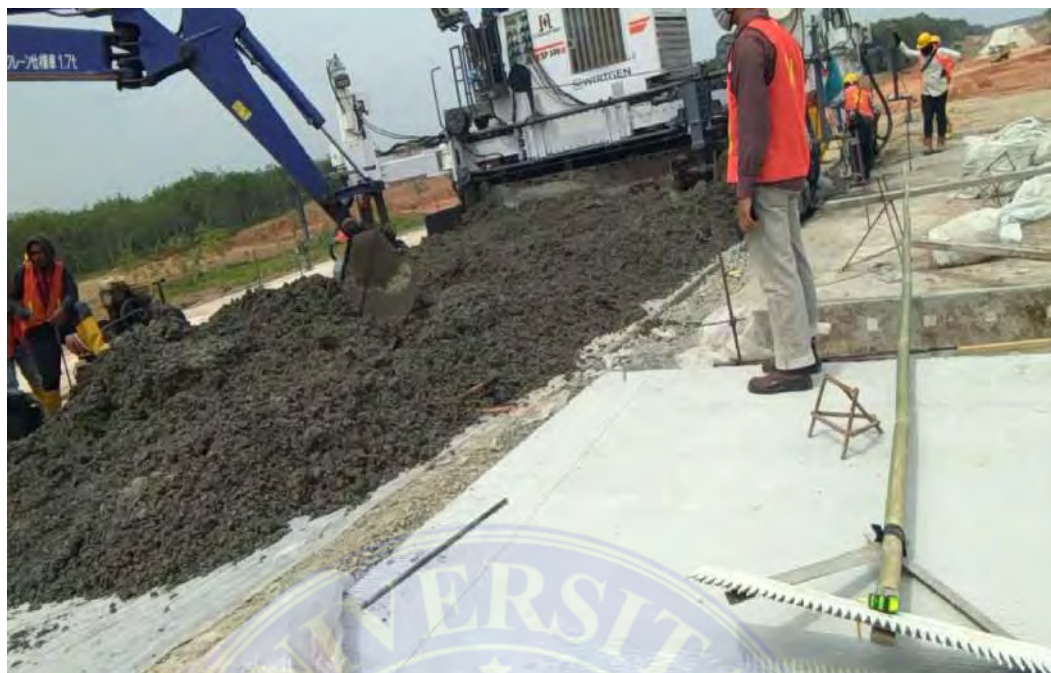
Proses meratakan campuran semen untuk perkerasan kaku
