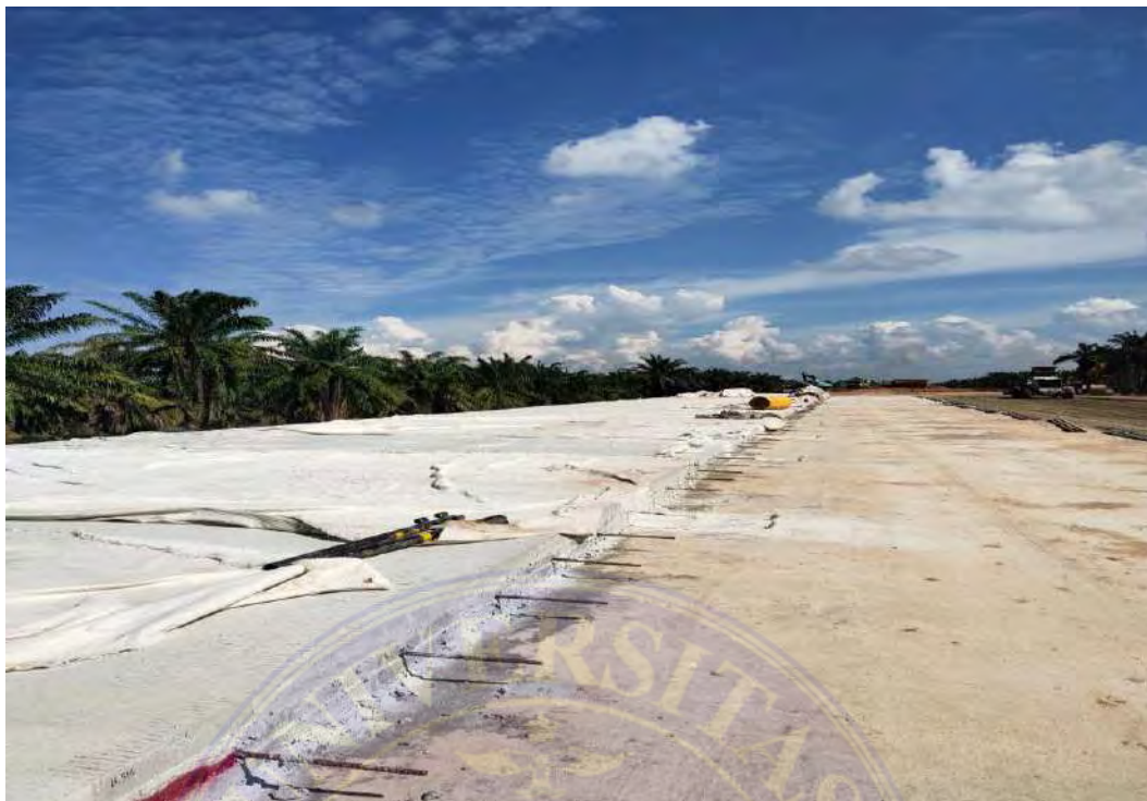
Rigid Pavement jalan tol Tebing Tinggi - Inderapura
