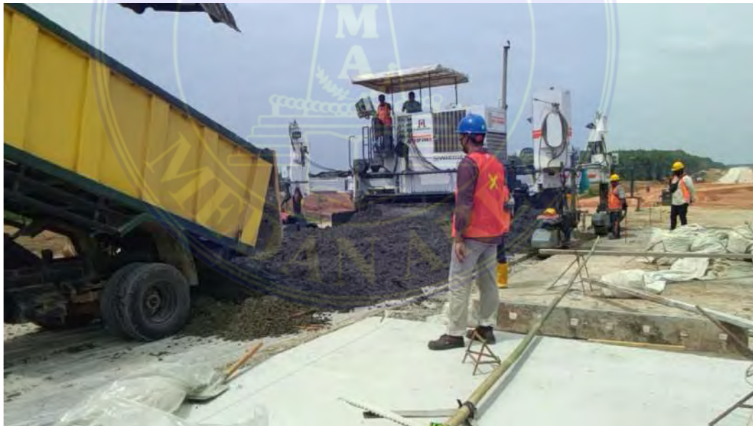
Proses penuangan campuran semen
