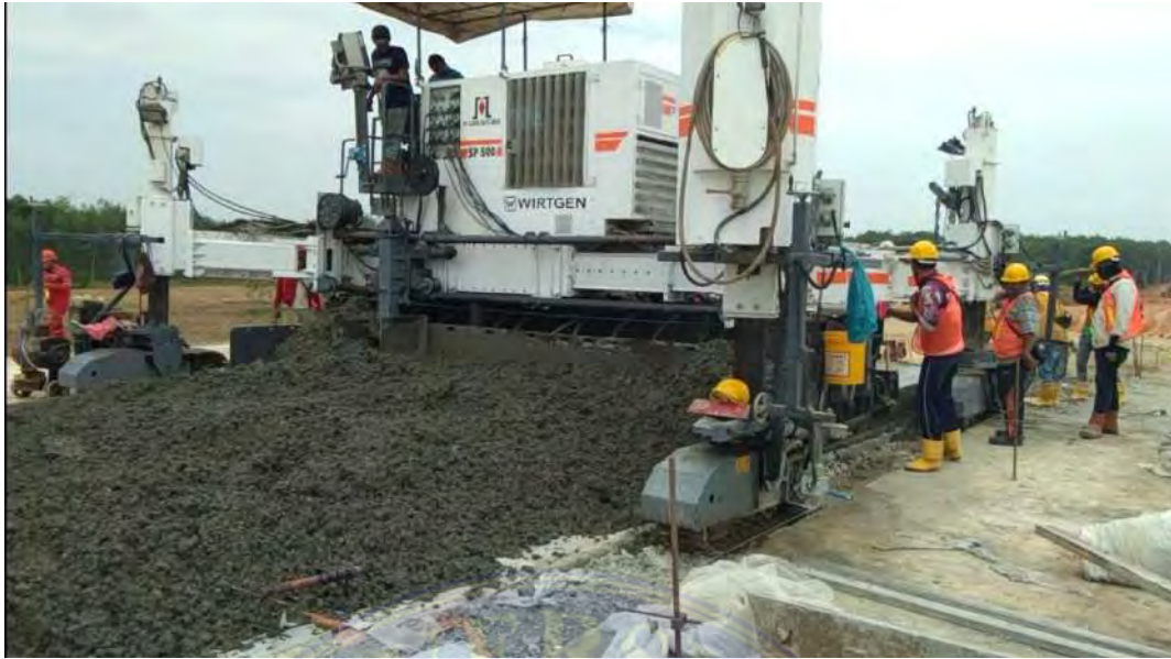
Proses pencetakan perkerasan kaku secara digital
