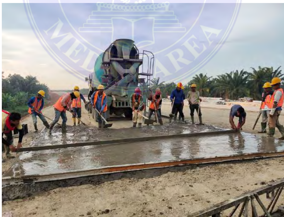
Proses pengecoran lean concrete (lantai kerja)
