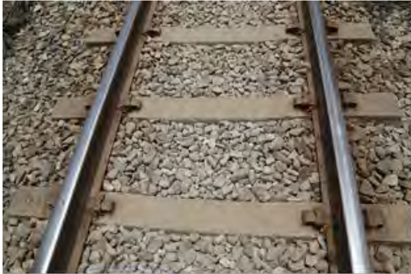
Gambar 2.9 Bantalan beton Sumber: (P. Rosyidi, Sri Atmaja. 2015)
