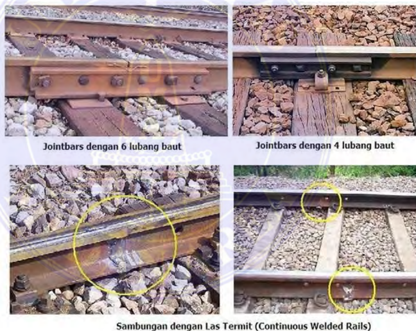
Gambar 2.4 Sambungan Rel Sumber: Sumber: (P. Rosyidi, Sri Atmaja. 2015)
