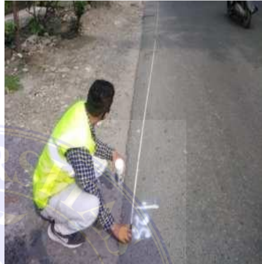
GambarB18 Penanda STA menggunakan pylox pada setiap segmen
