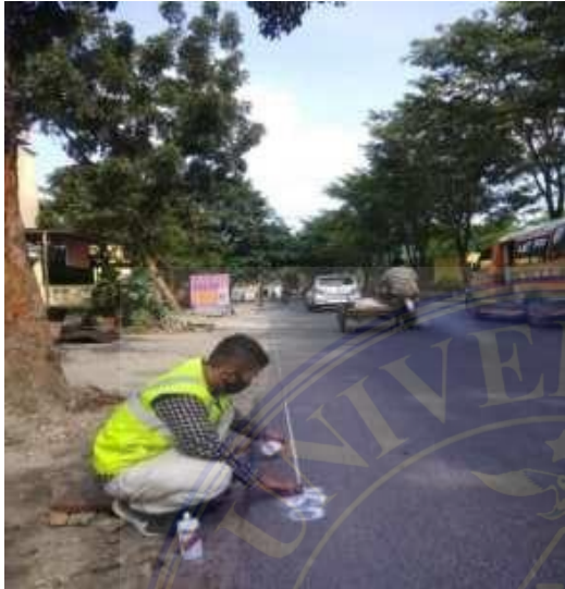
GambarB17 Pengukuran jarak per 50m
