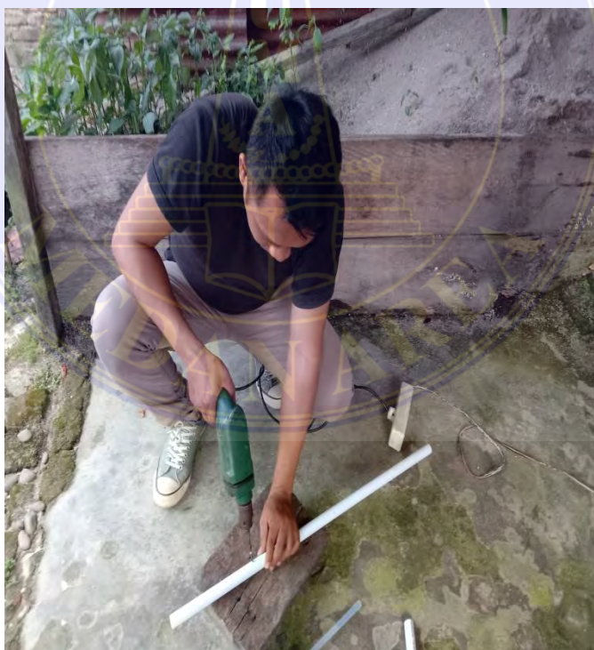
Lampiran 4: Pengeboran Lubang Yang Telah Diberi Jarak.
