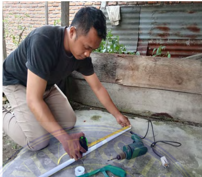
Lampiran 1: Pengukuran Pipa PVC Untuk Saluran Air Irigasi Tetes.
