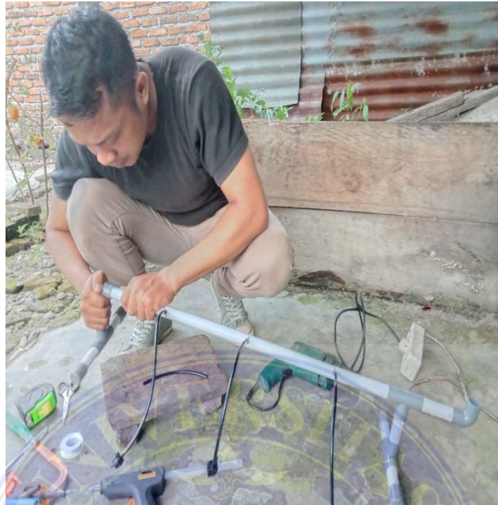
Lampiran 7: Perangkaian Instalasi Pipa PVC Dengan Selang Drip.
