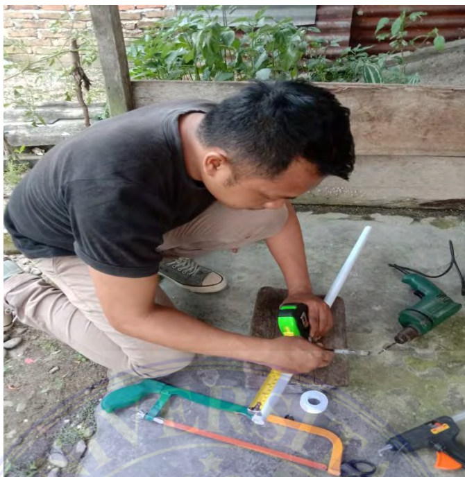
Lampiran 3: Pengukuran Jarak Setiap Lubang Irigasi.
