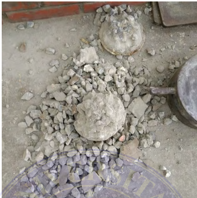
Beton yang hancur pada saat dilapisi belerang Sumber: Dokumentasi Penelitian 2022
