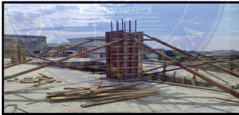
Gambar 4.2.1 bekisting kolom
