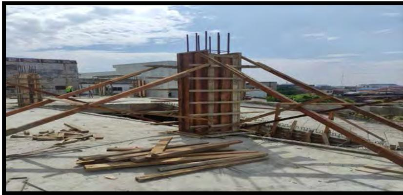
Gambar 4.2.1 bekisting kolom
