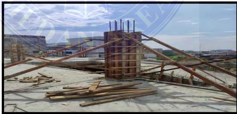
Gambar 4.2.1 bekisting kolom
