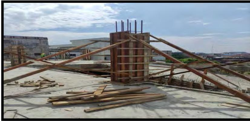
Gambar 4.2.1 bekisting kolom
