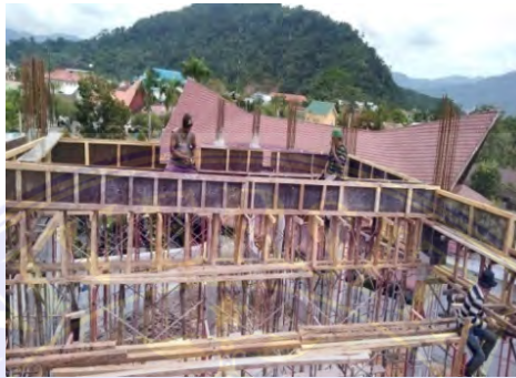
Gambar 4.25 Pekerjaan Bekisting balok Sumber : Dokumentasi Lapangan
