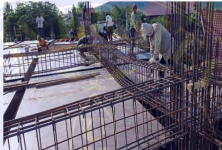
Gambar 4.29 Prose Pembersihan Pada Tulangan Sumber : Dokumentasi Lapangan
