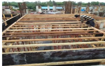
Gambar 4.22 Pekerjaan pemasangan Bekisting Balok dan Plat Lantai Sumber : Dokumentasi Lapangan
