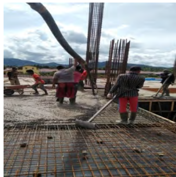
Gambar 4.32 Proses Pengecoran Balok Balok Dan Plat Lantai Sumber : Dokumentasi Lapangan
