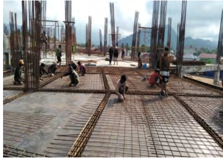
Gambar 4.22 Pemasangan Wiremesh Plat Lantai Sumber: Dokumentasi Lapangan
