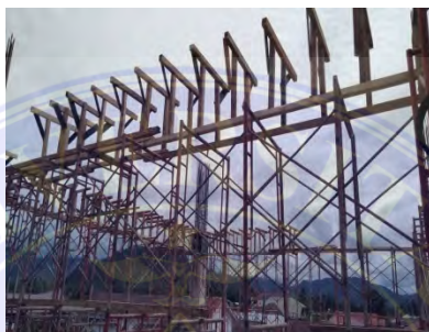
Gambar 4.23 Prose Pelaksanaan Bekisting Sumber : Dokumentasi Lapangan
