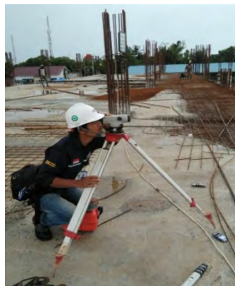
Gambar 4.24 Pengukuran elevasi titik balok dan kolom Sumber : Dokumentasi Lapangan
