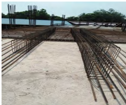
Gambar 4.21 Balok Induk Sumber: Dokumentasi Lapangan
