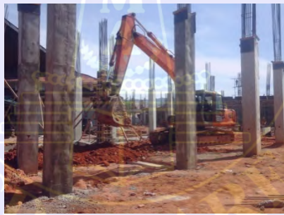
Gambar 4. 13 Alat Berat Excavator Sumber : Dokumentasi Lapangan
