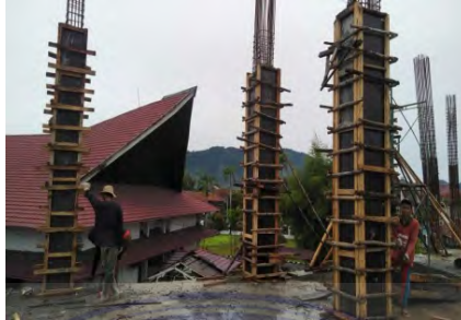
Gambar 4.20 Kolom Lantai Dua Sumber : Dokumentasi Lapangan
