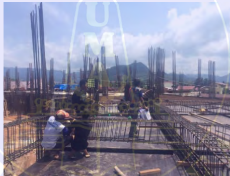
Gambar 4.28 Pekerjaan Pembesian Tulangan Sumber : Dokumentasi Lapangan
