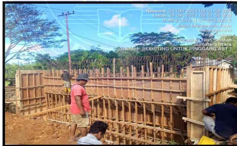
Gambar 4.6 Pemasangan Bekisting
