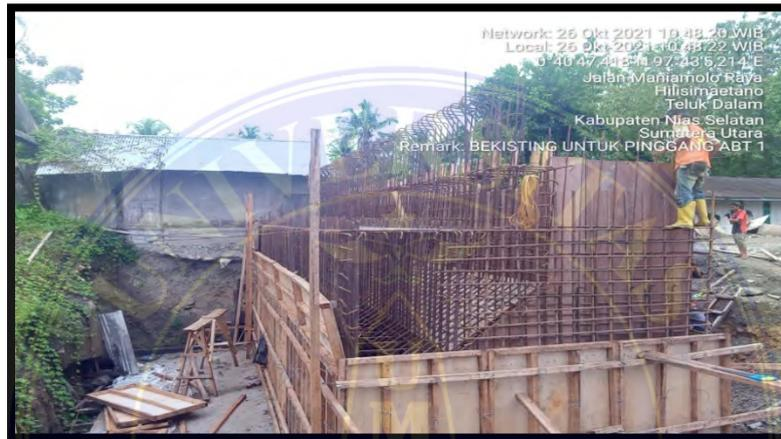
Gambar 4.5 Pemasangan Bekisting Untuk Pinggang
