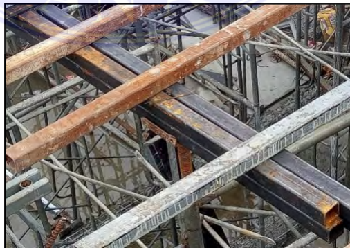
Gambar 4.28 Pemasangan U-Head dan Penampang
