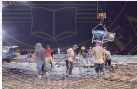
Gambar 4.31 Pengecoran plat lantai dan balok
