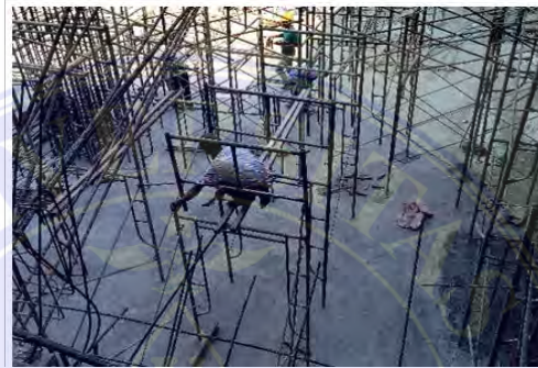
Gambar 4.27 Pemasangan Perancah
