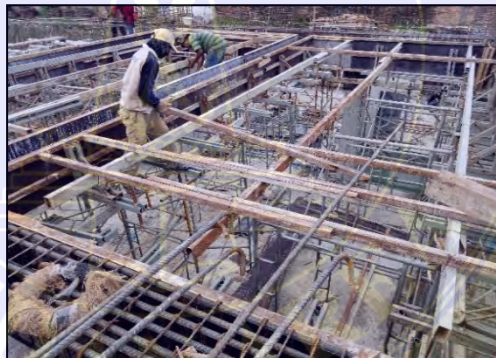
Gambar 4.27 Pemasangan Perancah
