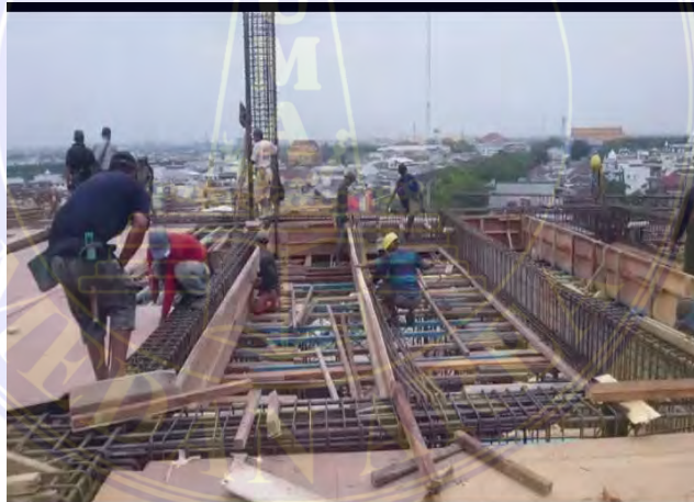
Gambar 4.30 Pemasangan bekisting
