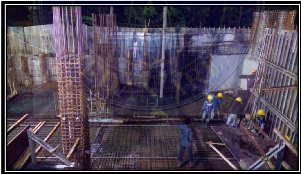
Gambar 14. Peletakan Konstruksi Kolom
