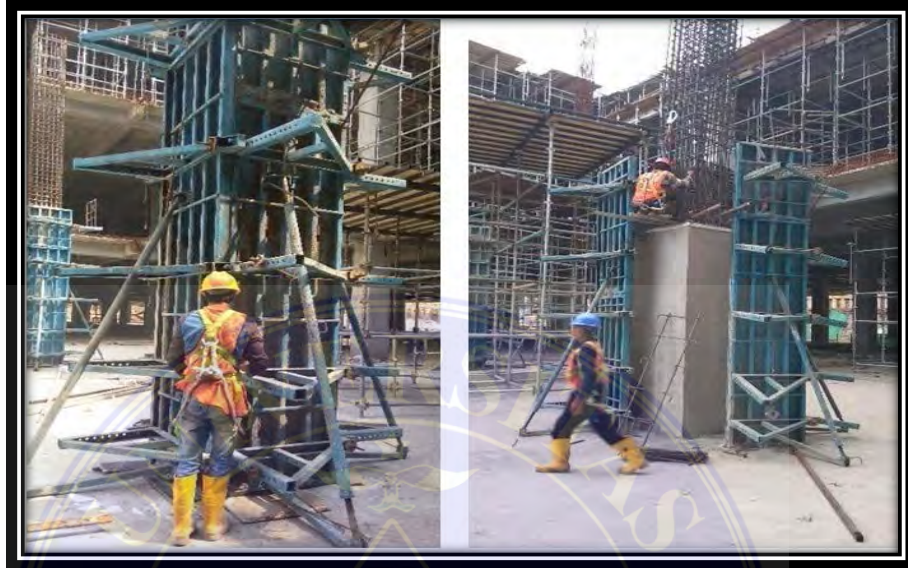
Gambar 4.6 Pengendoran Tierod dan Tie Nut Sumber Dokumentasi Pribadi
