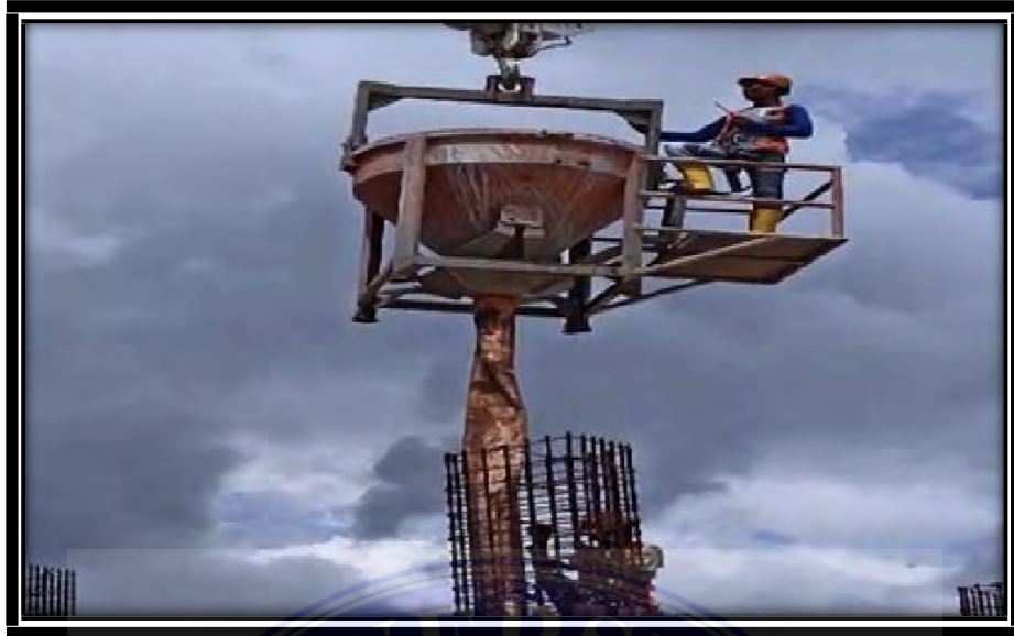
Gambar 4.7 Pengecoran Kolom Sumber Dokumentasi Pribadi
