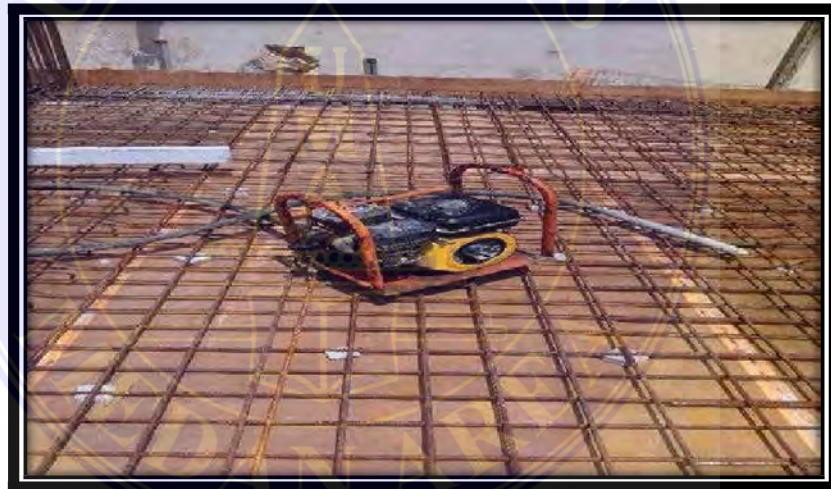
Gambar 3.11 Vibrator Sumber Dokumentasi Pribadi
