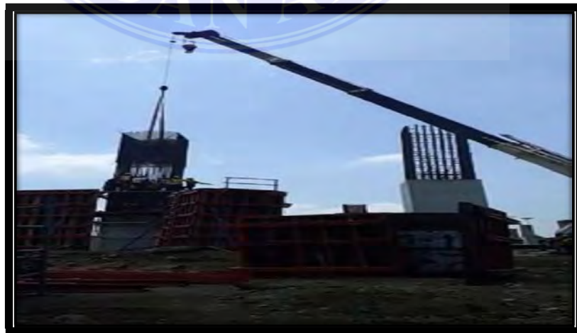
Gambar 3.14 Mobile Crane Sumber Dokumentasi Pribadi
