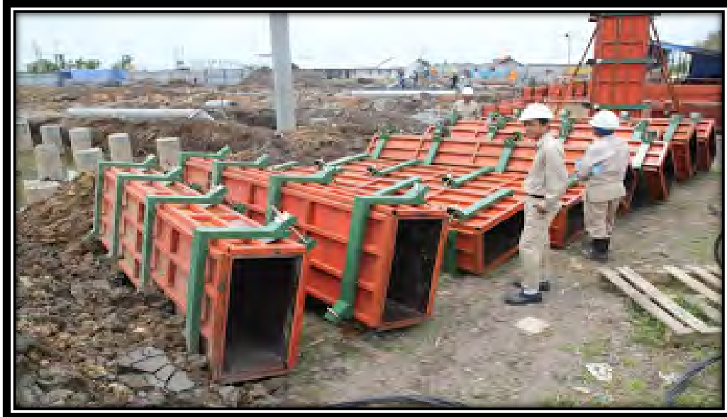
Gambar 15. Pemasangan Bekisting
