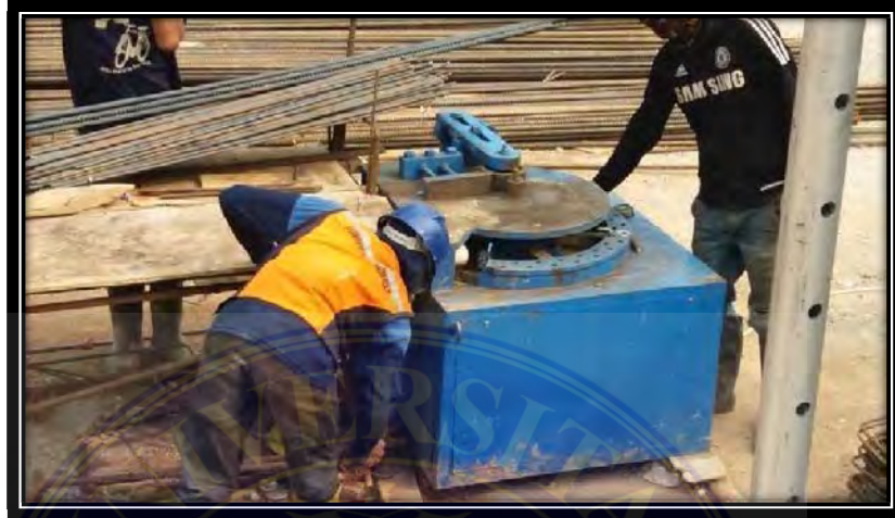
Gambar 3.13 Bar Bending Manual Sumber Dokumentasi Pribadi
