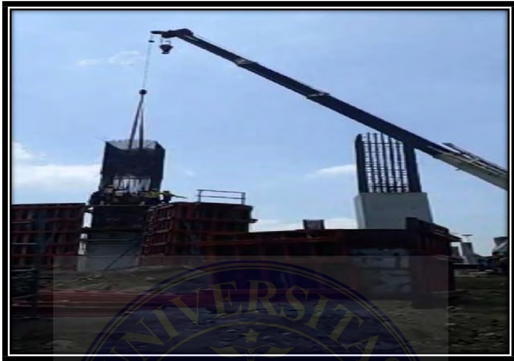
Gambar 13. Konstruksi Kolom diangkat Mobil Crane
