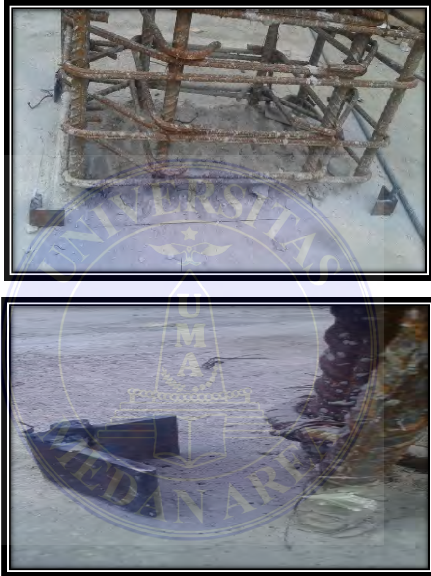
Gambar 4.4 Sepatu Kolom Sumber Dokumentasi Pribadi
