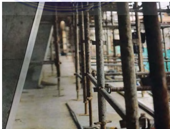
Gambar 3.21 Scaffolding atau Perancah
