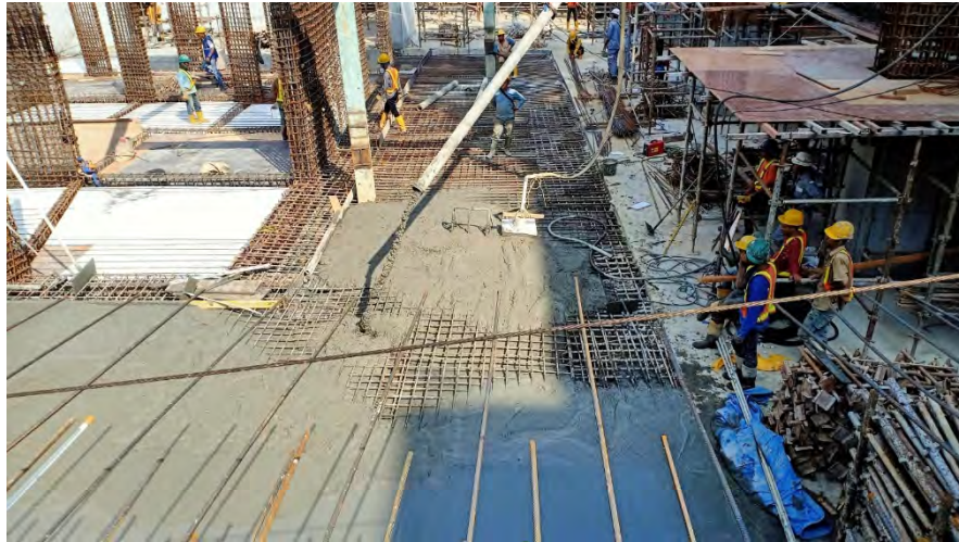
Gambar 3.28 Pekerjaan Pengecoran
