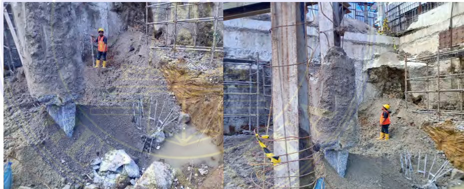
Gambar 3.2 Pondasi Boredpile
