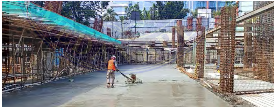
Gambar 3.17 Penggunaan alat Power Trowel
