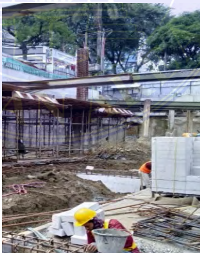
Gambar 4.2 pemasangan Bata Hebel
