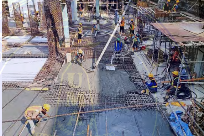
Gambar 4.8 Proses pemadatan dengan vibrator
