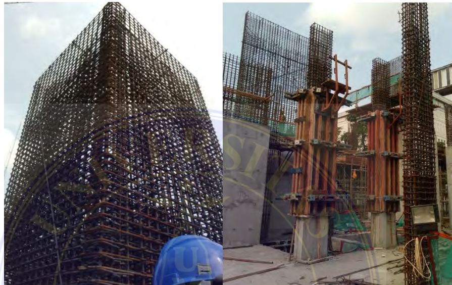
Gambar 3.9 Pekerjaan Penulangan dan Pemasangan Bekisting Pada Shear Wall
