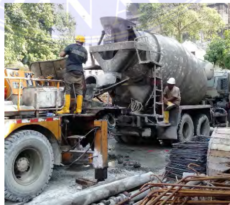
Gambar 4.7 Proses Pemindahan beton segar dari truck ready mix
