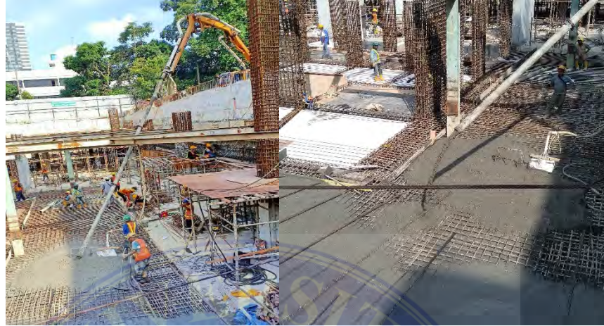
Gambar 4.6 Proses Pengecoran Tie beam dan Plat Lantai
