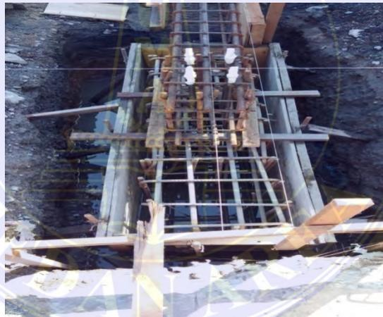
Gambar 4.12 Pembesian dan Pemasangan Bekisting *Pile Cap*
