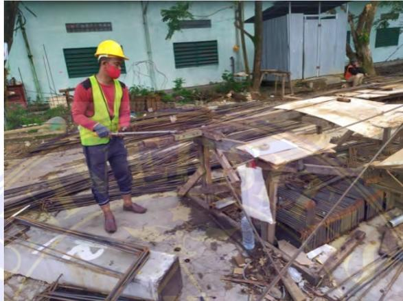
Gambar 3.7 *Bar Bending*
