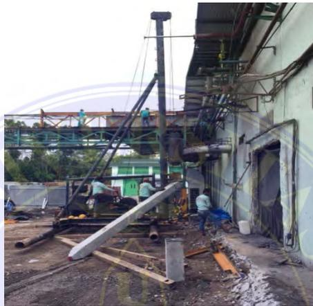
Gambar 4.2 Proses Pengangkatan Tiang Pancang
