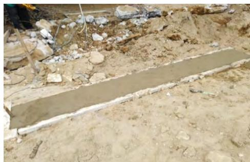
Gambar 4.7 Pengecoran Lantai Kerja
