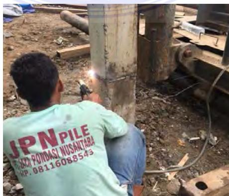
Gambar 4.3 Proses Penyambungan Tiang Pancang
