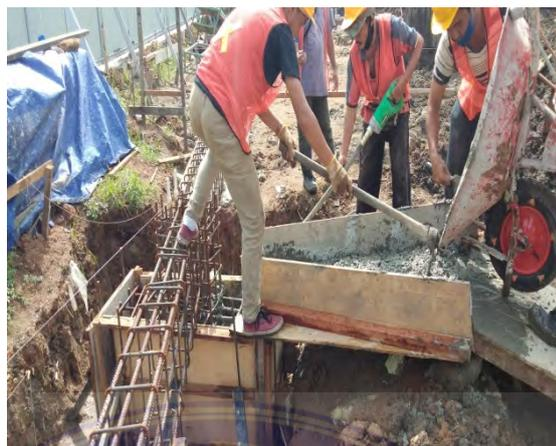
Gambar : 4.15 Pengecoran *Pile Cap*
