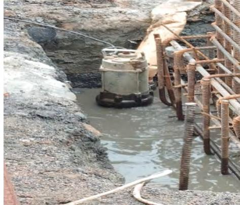
Gambar 4.14 Pekerjaan *Dewatering*
