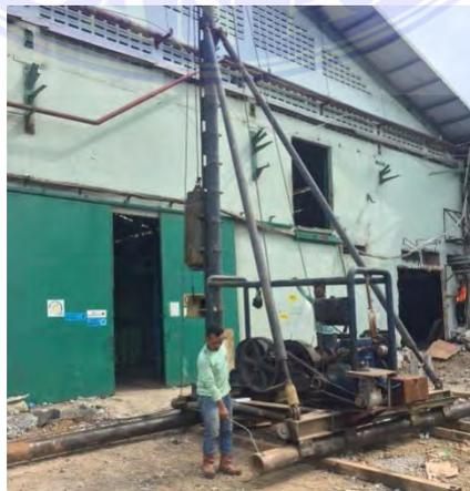
Gambar 4.1 Proses Penempatan *Drop Hammer*
