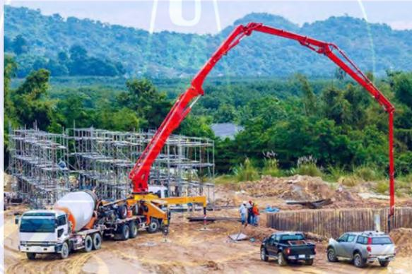
Gambar 4.56 Pengecoran dengan *Concrete Pump*
