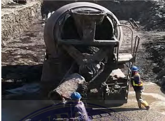
Gambar 4.55 Pengecoran dengan *truck mixer*
