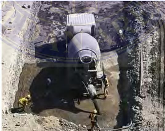
Gambar 4.47 Pengecoran lantai kerja
