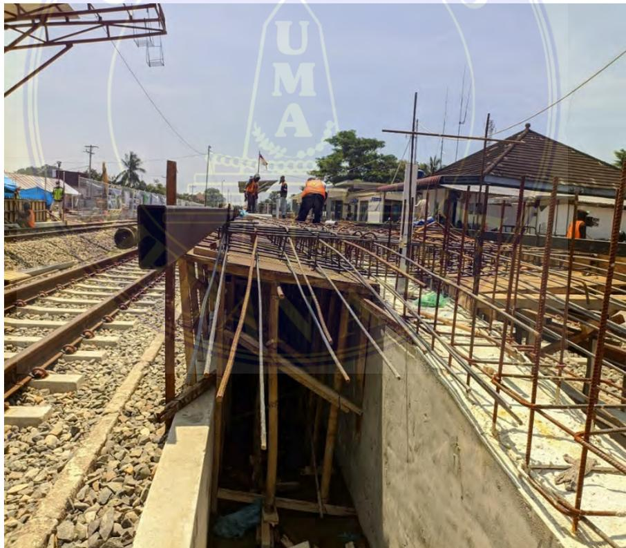
Gambar 4.4 Pemasangan Bekisting
