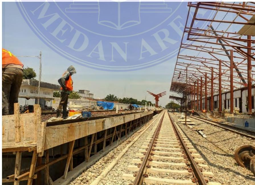
Gambar : Pemasangan bekisting
