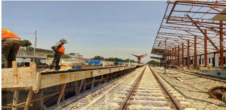
Gambar 4. 1 Pemasangan Bekisting
