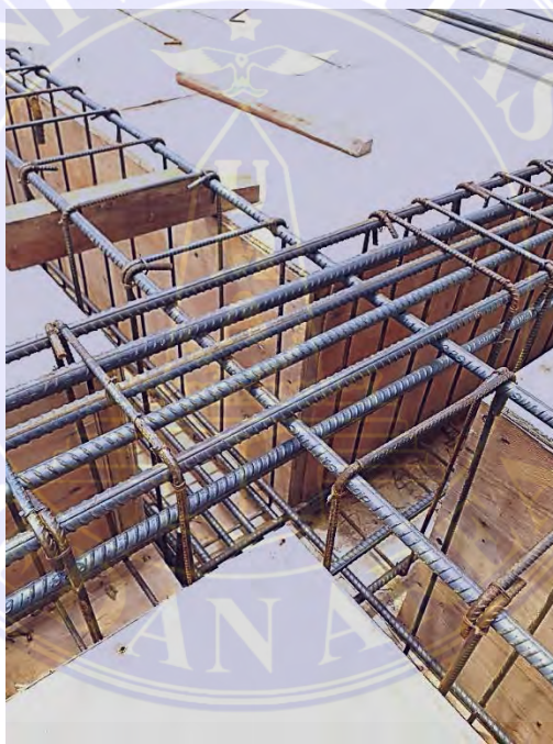
Gambar 4.5 Penulangan Pada Balok Induk dan Balok Anak
