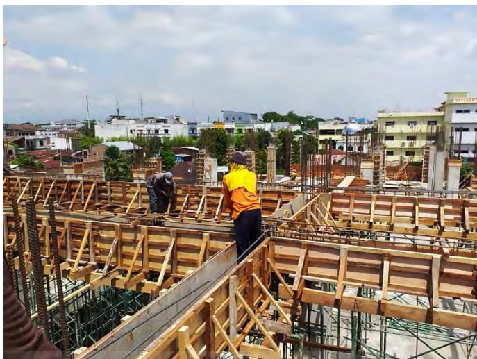
Gambar 4.4 Pengerjaan Penulangan Diatas Bekisting Balok
