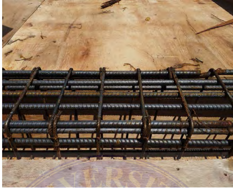
Gambar 4.6 Penulangan Balok (Sumber : Dokumentasi Pribadi 2021)
