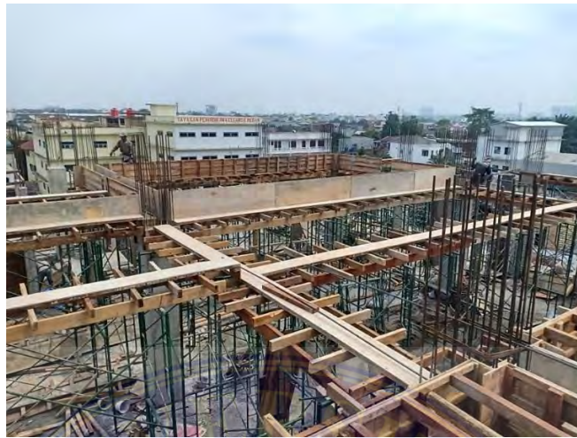
Gambar 4.3 Perakitan Bekisting Balok (Sumber : Dokumentasi Pribadi 2021)
