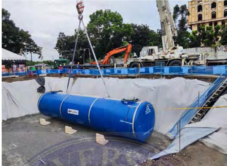
Gambar 4.5 Proses peletakan Tanki
