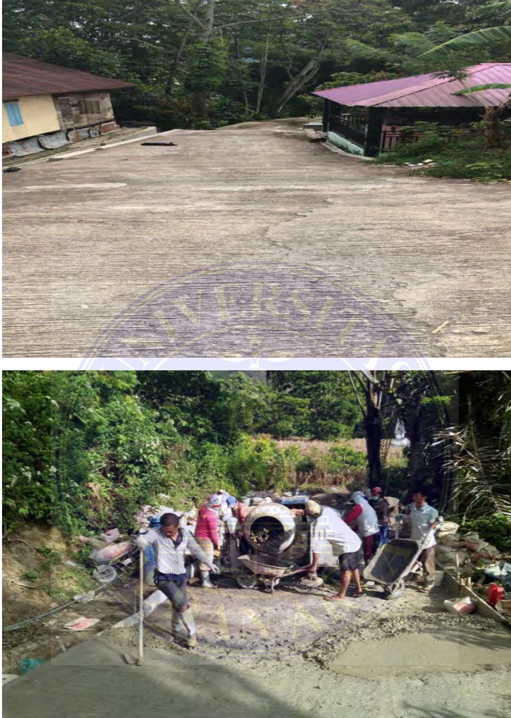
Gambar 10. Kegiatan Pembangunan Pembangunan Jalan Jior (Sumber: Dokumen Pribadi, Jumat, 17 Maret 2022)
