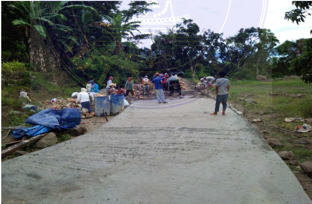
Gambar 12. Kegiatan Pembangunan Rabat Beton Jalan Lumban Nainggolan (Sumber : Dokumen Pribadi, 17 Maret 2022)
