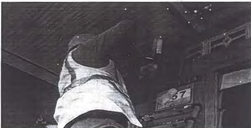
Gambar.3 staff sedang melakukan pemasangan kWh meter
