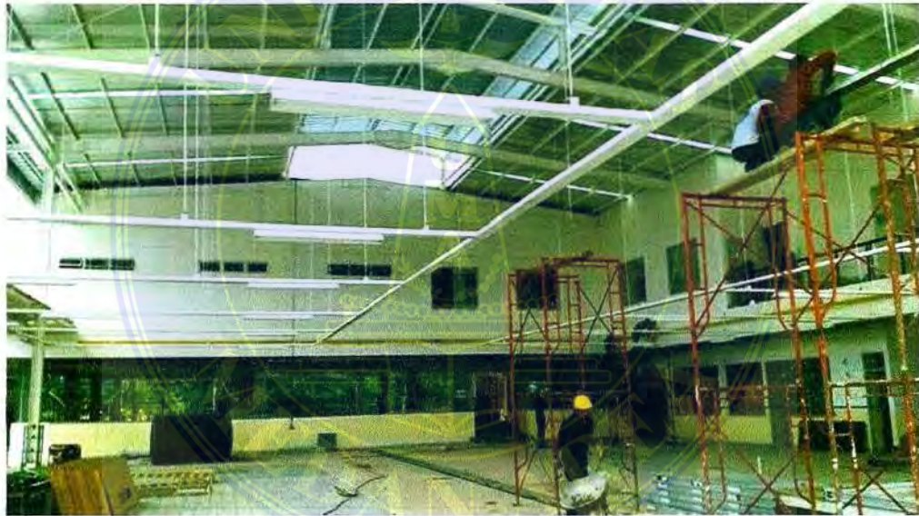
Gambar 3.6.5. Pemeriksaan Pemasangan Instalasi
