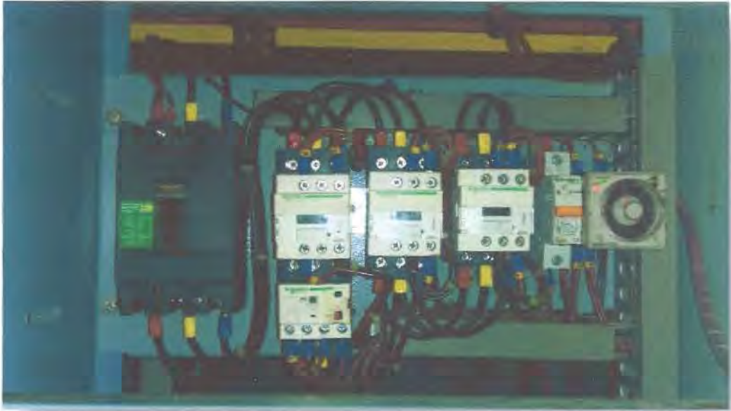
Gambar 3.13: rangkaian daya dan rangkaian kontrol pengasutan bintang segitiga (Sumber: Penulis, 2020)
