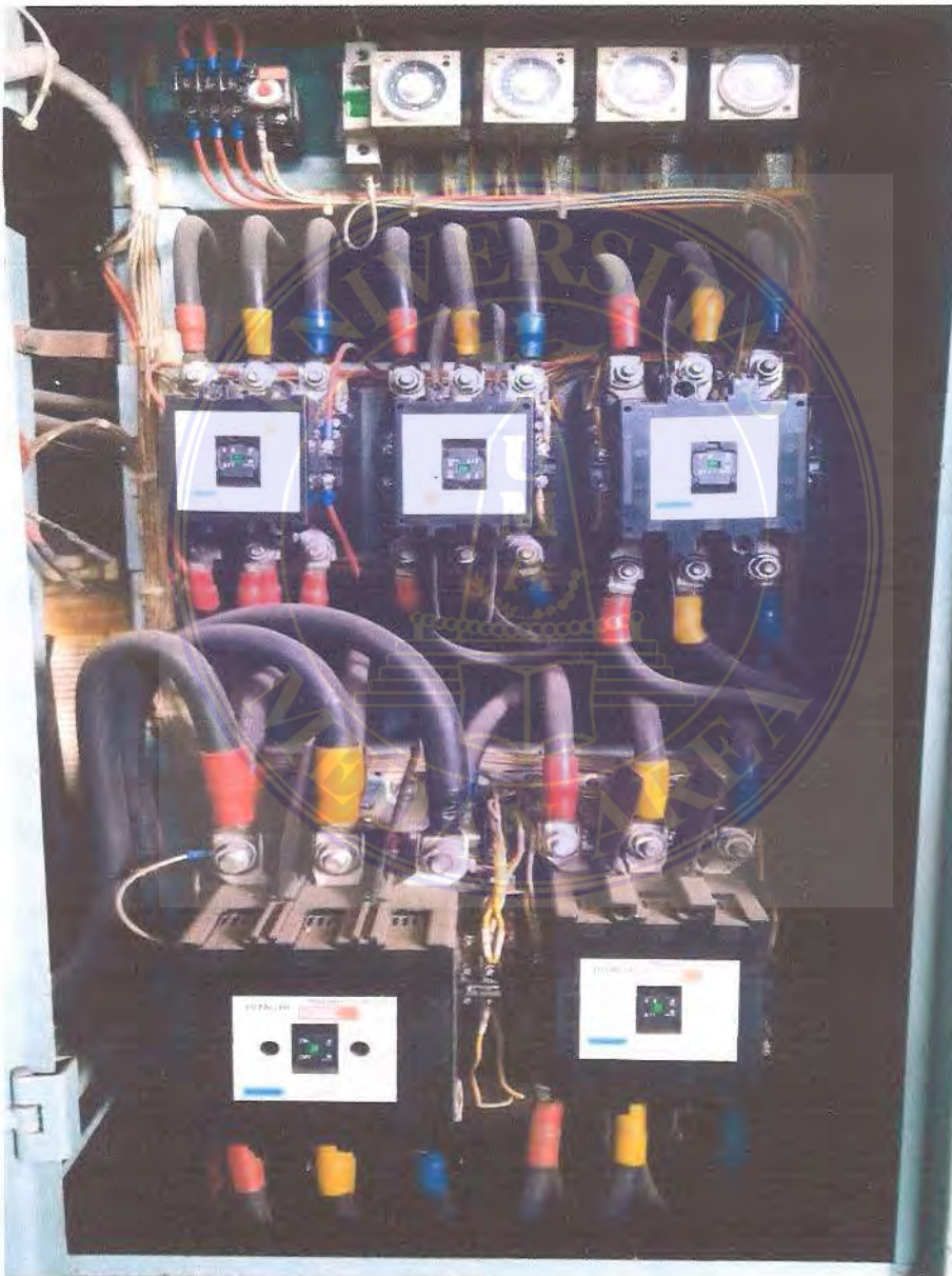
Gambar 3.14: Fisik Rangkaian Kontrol Ototrafo (Sumber: Penulis, 2020)
