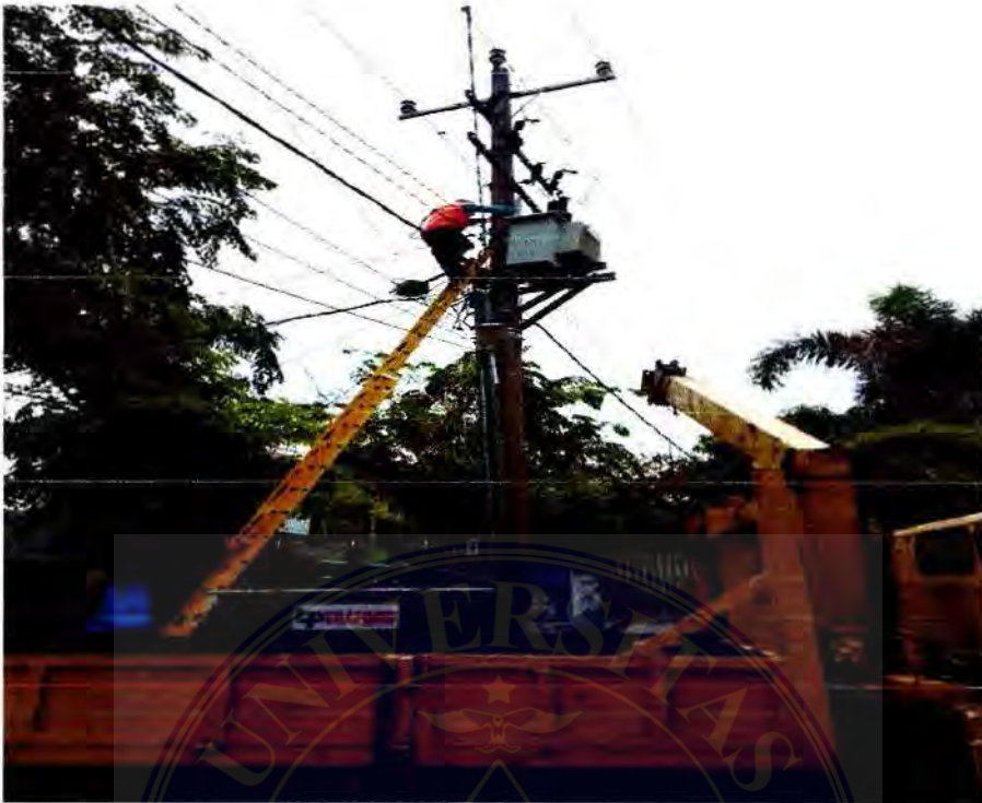
Gambar 2.4: Mengganti Trafo Kontak dengan yang Baru
