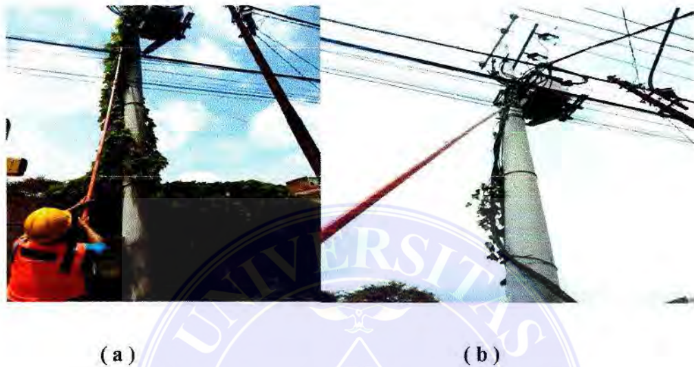
Gambar 2.3: ( a ) pembersihan rumput-rumput yg menjalar ( b ) Gambar sesudah di bersihkan
