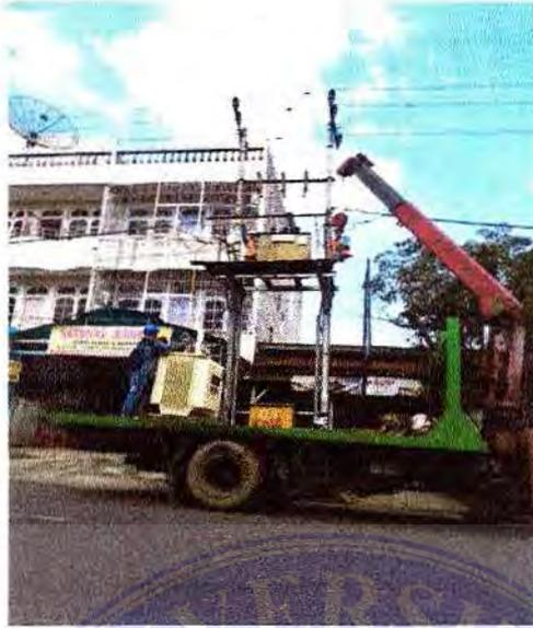
*Gambar 3.1 penggantian trafo distribusi 250 KVA*
