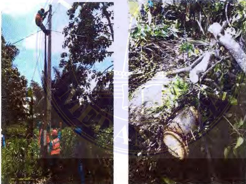
*Gambar 3.3 Perbaikan kabel JTR yang di timpa pohon*
