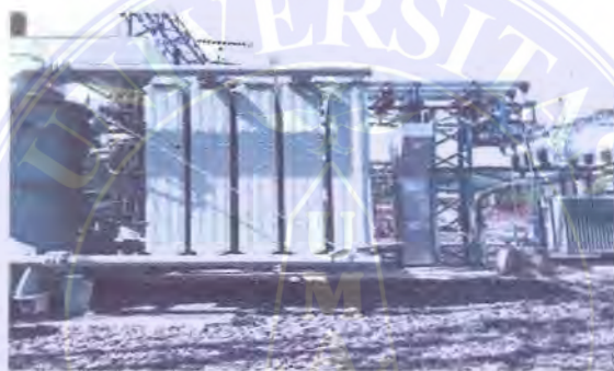
Gambar 2.8 Pendingin Trafo type ONAF
