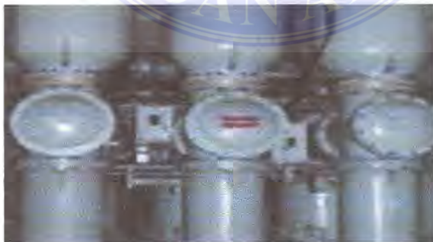
Gambar 2.17. Pemutus Tenaga (PMT) pada Gardu Induk Tanjung Morawa Yang menggunakan media pemadam busur api gas SF 6
