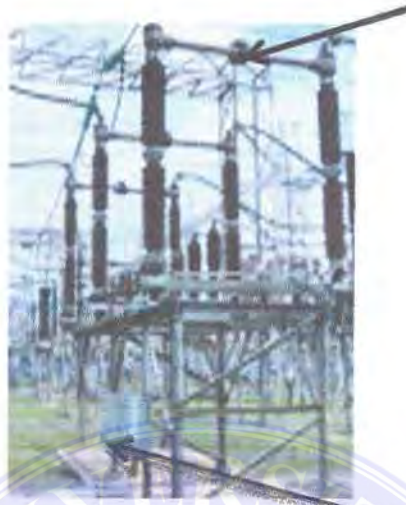
mekanik penggerak Gambar 2.20. Pemisah siku
