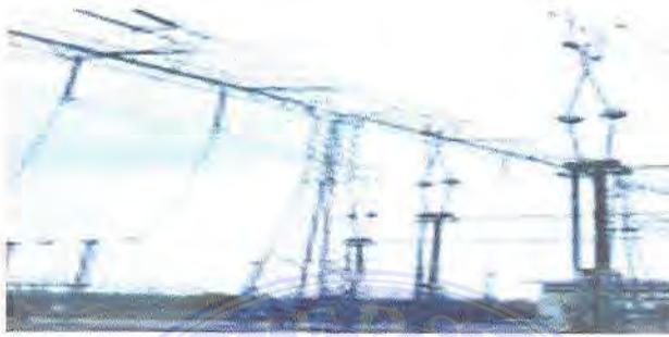
Gambar 2.22. pemisah pantograp
