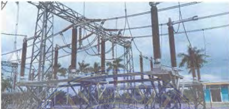
Gambar 2.18. Pemisah Engsel
