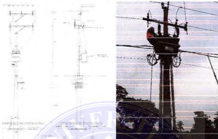
Gambar 2 28 Penempatan Arrestor dan CO Pada Tiang Trafo Single Pole Sumber : Adrianus Darso Malendes, 2015 dan Siantar,2021 (dokumen pribadi)
