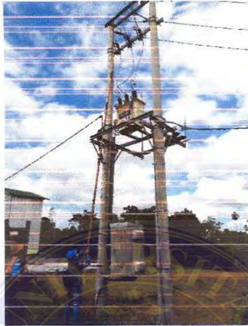
Gambar 2 9 Gardu Portal Sumber : Siantar,2021 (dokumen pribadi)
