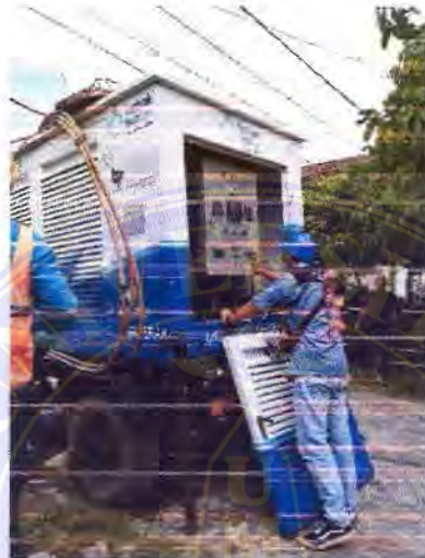
Gambar 2 11 Gardu Mobil Sumber : Siantar, 2021 (dokumen pribadi)
