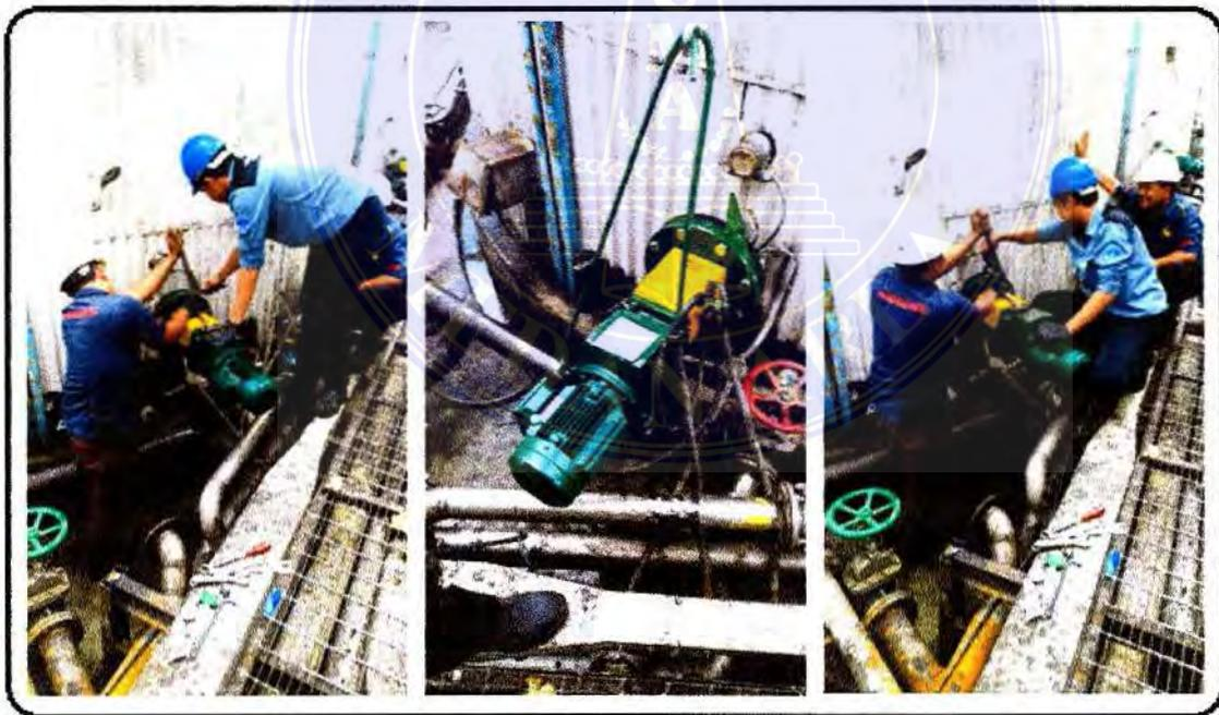
Gambar 17. Proses instalasi rangkaian pada *agitator*
