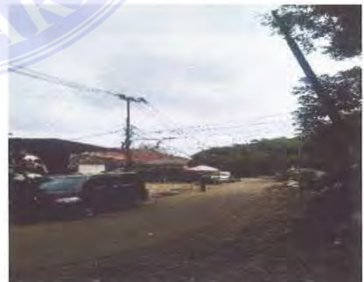
Gambar 3 7 Sebelum Perbaikan Traves
