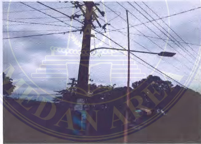
Gambar 3 16 Pengecekan kembali pin isolator
