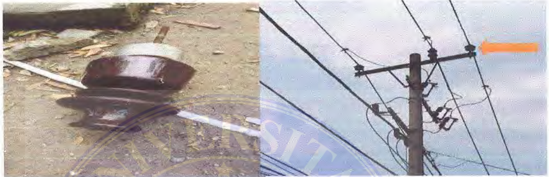
Gambar 3 13Mengganti Pin Isolator
