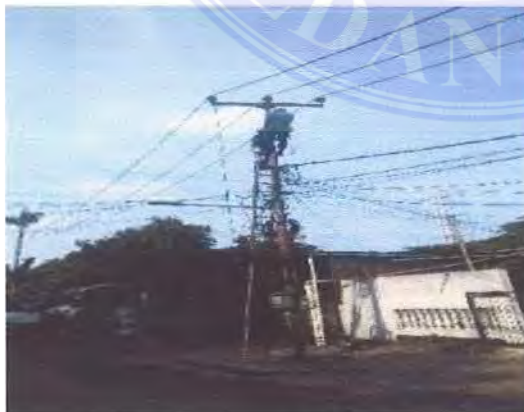
Gambar 3 8 Sesudah Perbaikan Traves
