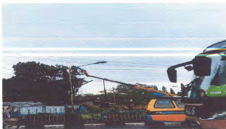
Gambar 3 10 Perampalan pohon yang mengenai SUTM
