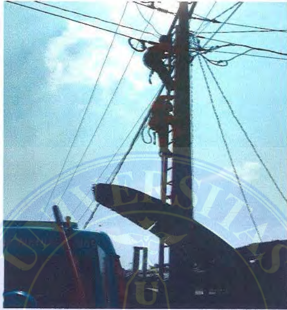
Penggantian Jumper Pada TM
