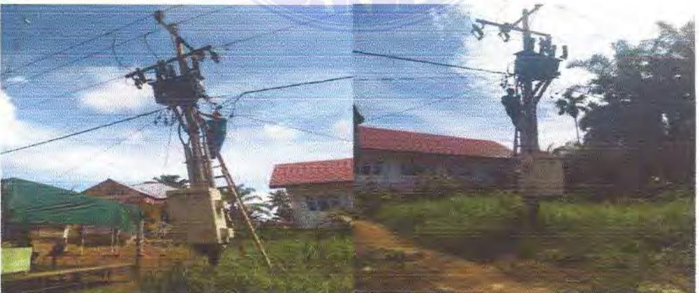
Gambar 3.11 : Pengencangan Connector pada Saluran Rumah (SR) milik konsumen
