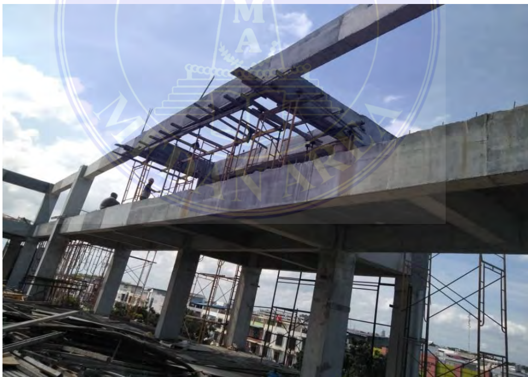
“Tampak Struktur Atas Dudukan Struktur Baja Pembangunan Gedung Rektorat dan Auditorium AKPAR Medan” (Sumber : Dokumentasi Lapangan, 2022)
