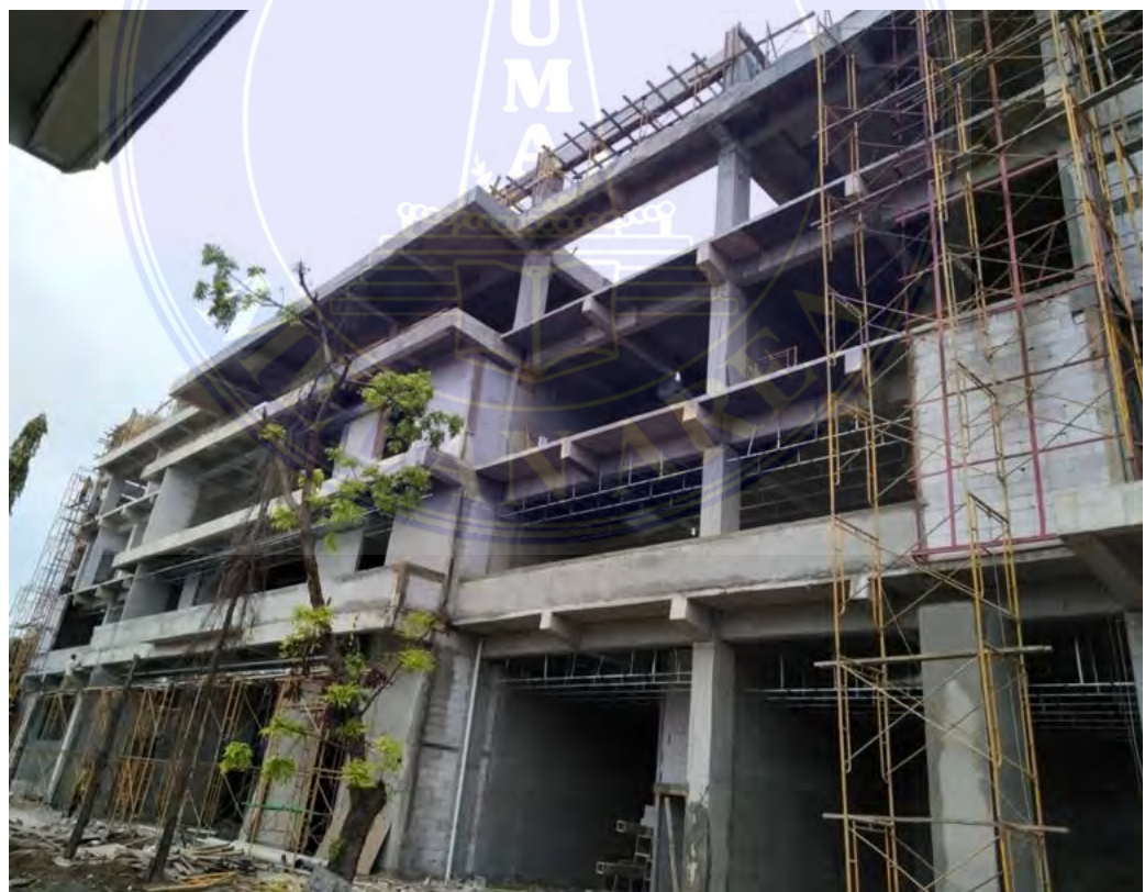
“Tampak Struktur Belakang Pembangunan Gedung Rektorat dan Auditorium AKPAR Medan” (Sumber : Dokumentasi Lapangan, 2022)
