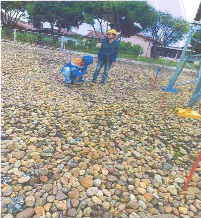
Gambar 18. Pengecekan dan Pengukuran Pentanahan
