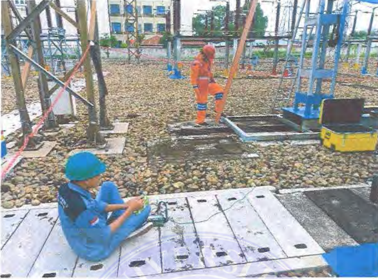
Gambar 17. Pengecekan dan Pengukuran Pentanahan
