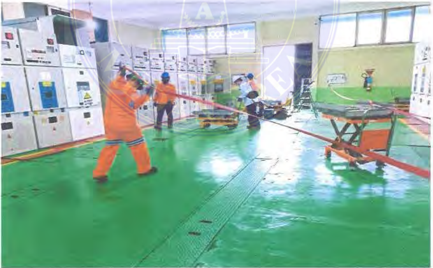
Gambar 15. Pelaksanaan Pemasangan Warning Cross Line Area
