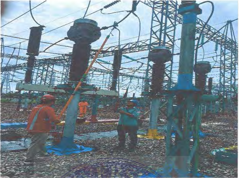
Gambar 14. Pelaksanaan Pemasangan Grounding Pentanahan
