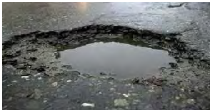
Gambar 2.14 Lubang Sumber : Dirjen Bina Marga 2017
