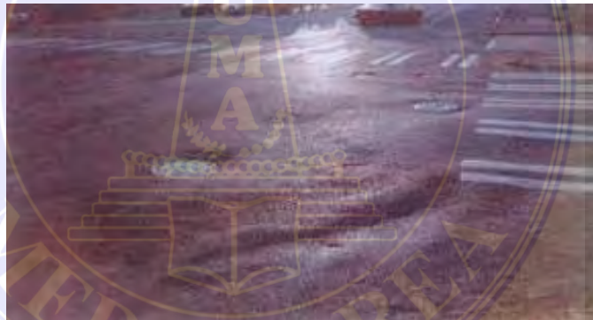
Gambar 2.6. Keriting Sumber : Dirjen Bina Marga 2017
