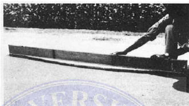
Gambar 2.7. Ambles Sumber : Dirjen Bina Marga 2017
