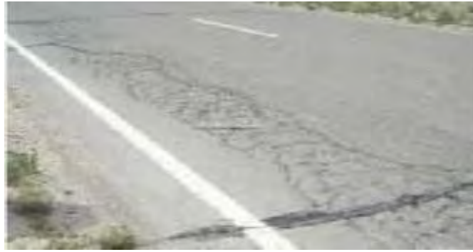
Gambar 2.2. Retak Kulit Buaya
