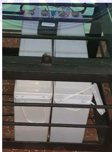
Gambar 3.4 : Baterrai SMT VRLA 12 Volt 175 Ah
