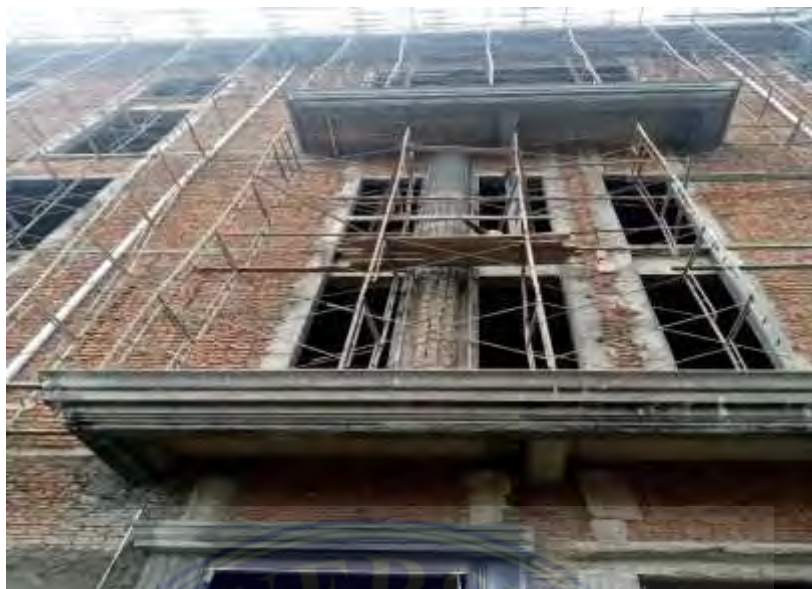
“Pekerjaan Dinding Batu Bata”
