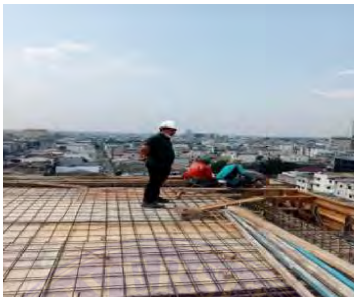
“Penulangan Plat Lantai”
