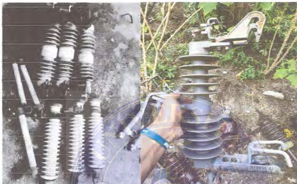
Gambar 4.1 FCO dan Lightning Arrester yang rusak
