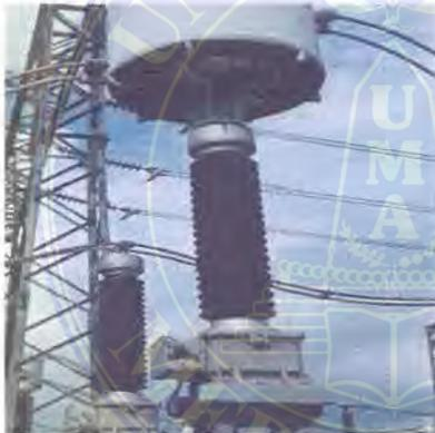
Gambar 2.13. Transformator Tegangan (Voltage Transformer) pada GI Tanjung morawa
