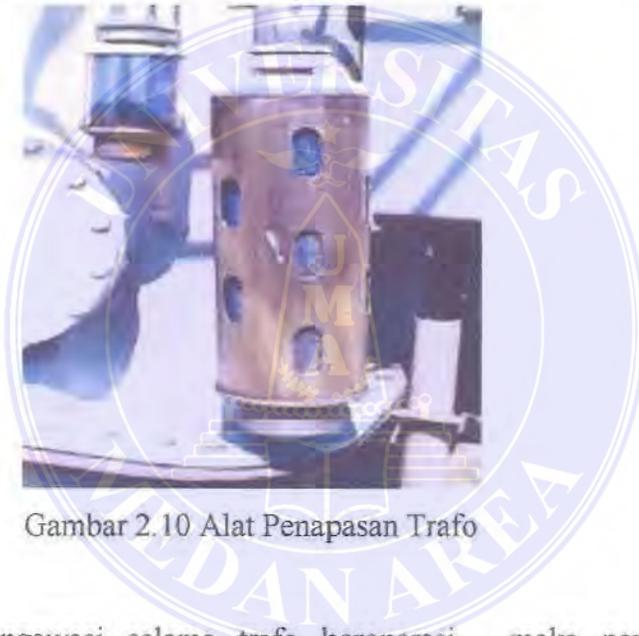
Gambar 2.10 Alat Penapasan Trafo
