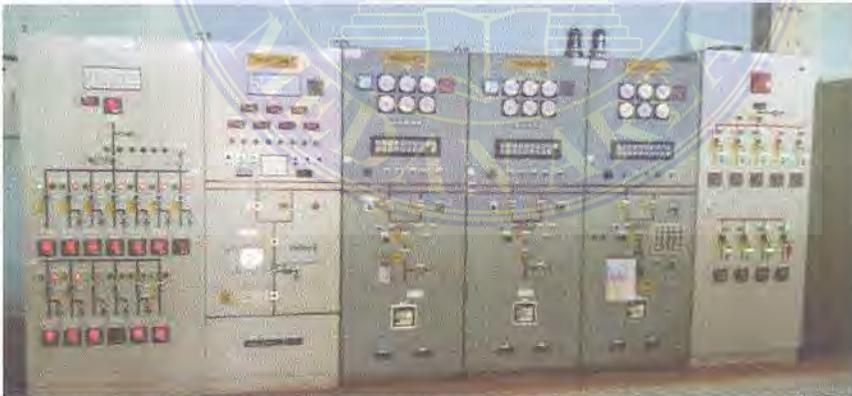
Gambar 2.28. Panel kontrol penghantar 150 kv dan Panel kontrol Bay Couple Bus 150 kv
