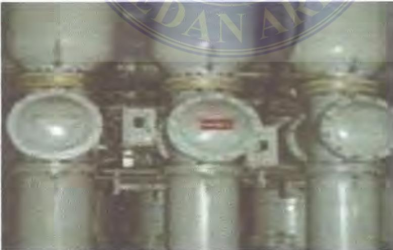
Gambar 2.17. Pemutus Tenaga (PMT) pada Gardu Induk Tanjung Morawa Yang menggunakan media pemadam busur api gas SF<sub>6</sub>
