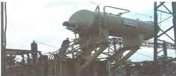
Gambar 2.7. Bentuk Tangki Konservator Pda Trafo Daya
