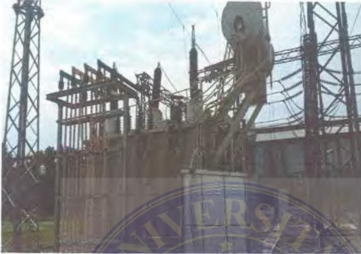
Gambar 2.3. Transformator Daya 3 (TD-3) di GI tanjung Morawa
