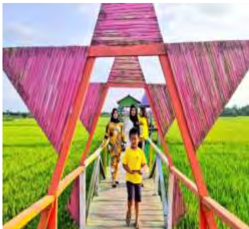
Gambar. 17 Jembatan Paloh Naga
