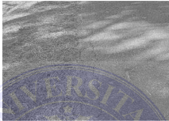
Gambar 2.3 Retak Tepi
