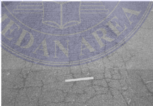
Gambar 2.1 Retak Kulit Buaya
