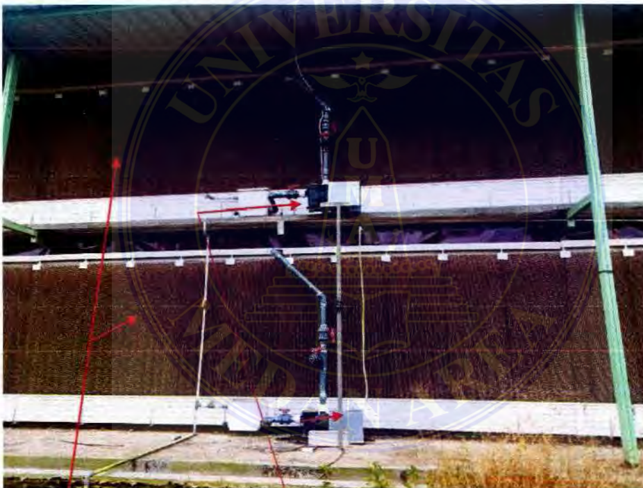
Gambar 4.3 cooling pump pada kandang PT KSM medan 2
