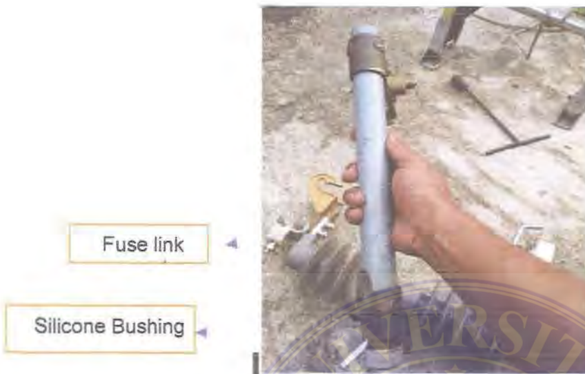
Gambar 3. 9 Memasang Fuse Link pada FCO
