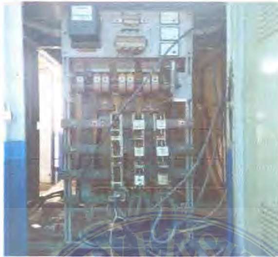
Gambar 2.11 Konstruksi Kotak PHB-TR
