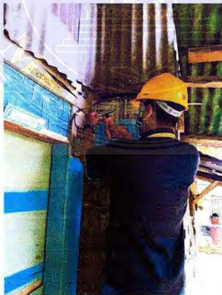
Gambar 2 penyambungan sementara listrik pelanggan kwh meter eror
