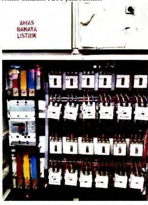
**Gambar 2. Panel penggunaan ACB (Air Circuit Breaker ) dan PMT lainnya**
