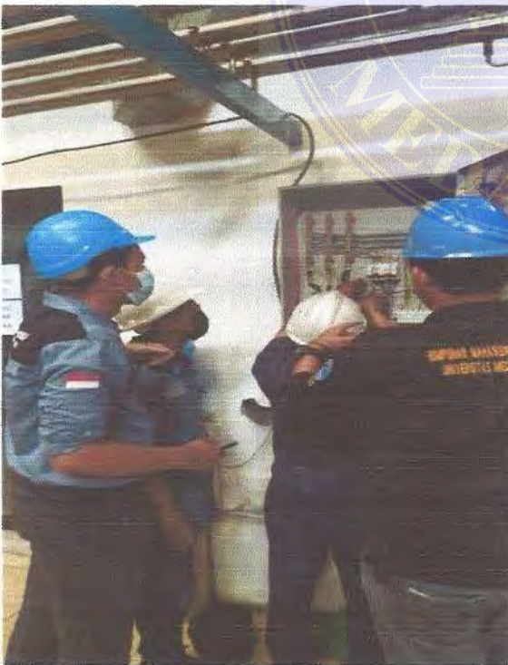
MERAPIKAN KABEL PADA PANEL MARGARIN
