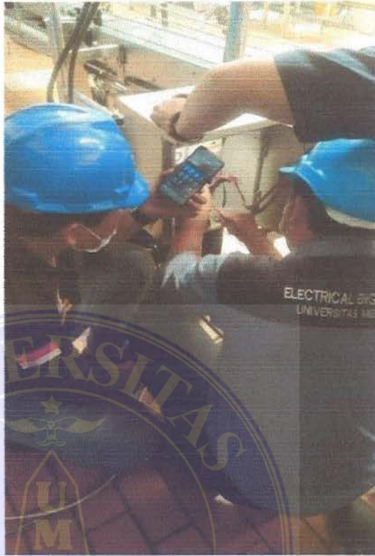
MERAPIKAN KABEL DI CONVEYER
