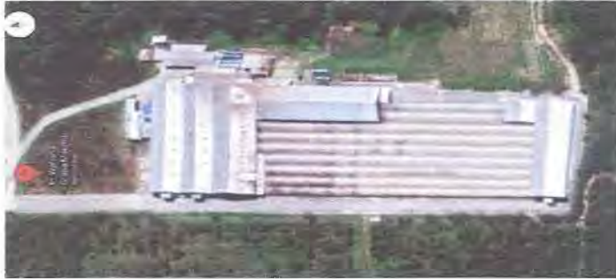
Gambar 2.2. Foto Lingkungan Pabrik
