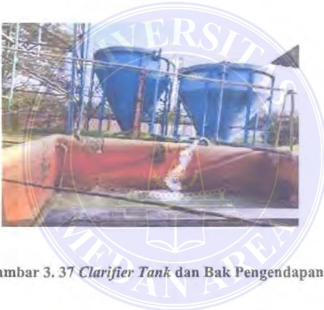
Gambar 3. 37 *Clarifier Tank* dan Bak Pengendapan
