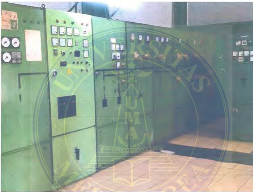
Gambar 3.47. Lemari Pembangkit Listrik
