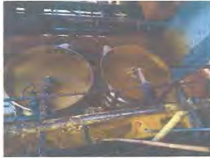
Gambar 3. 14 Sludge Tunk Dan Oil Tank
