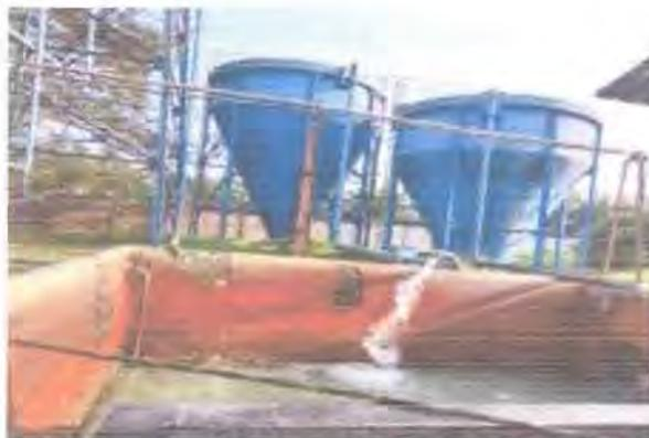
**Gambar 3. 37 Clarifier Tank dan Bak Pengendapan**
