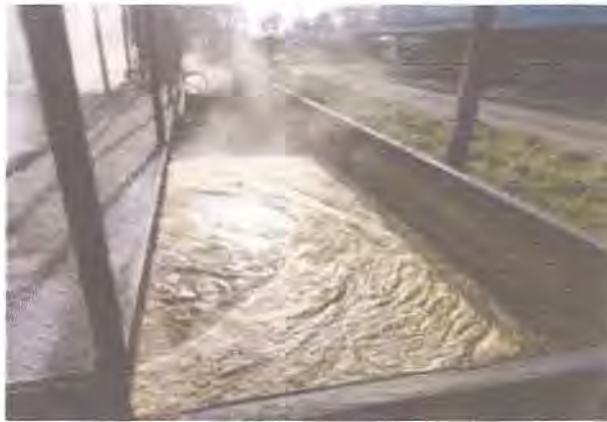
Gambar 3. 34 Stasiun Fat - Pit
