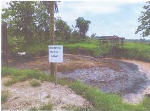
Gambar 3.2 Deoling Pond Sumber : ( Dokumentasi kerja praktik)
