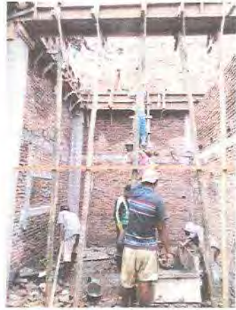
Gambar.12 Proses pengangkutan cor
