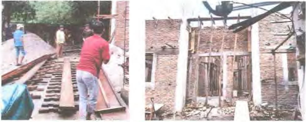
Gambar.10 Proses Pemasangan Bekisting
