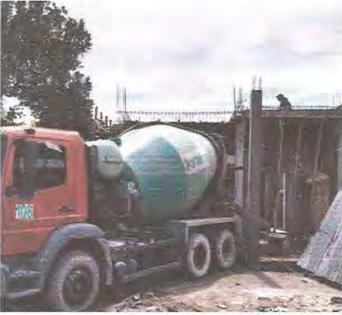
Gambar.11 Proses pengecoran balok
