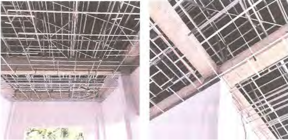
Gambar.7 Proses pemasangan rangka plafon
