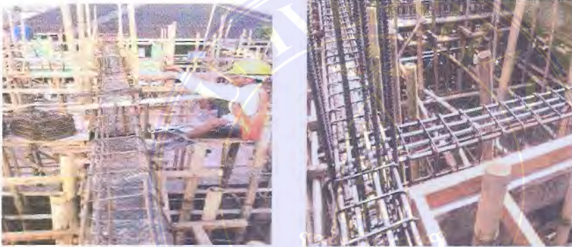
Gambar.9 Proses Pembesian Balok
