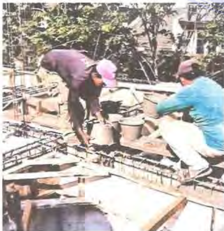
Gambar.1 Proses pengecoran
