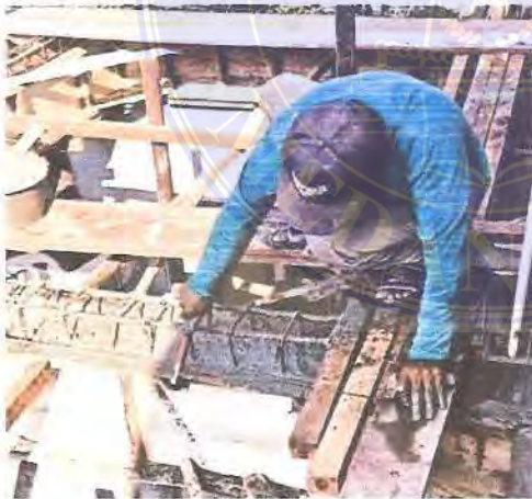
Gambar.13 proses pengecoran manual
