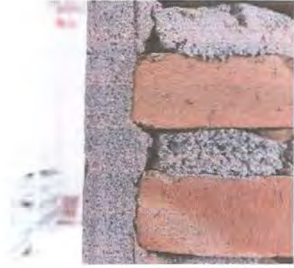
Gambar.3 Setelah kering plasteran
